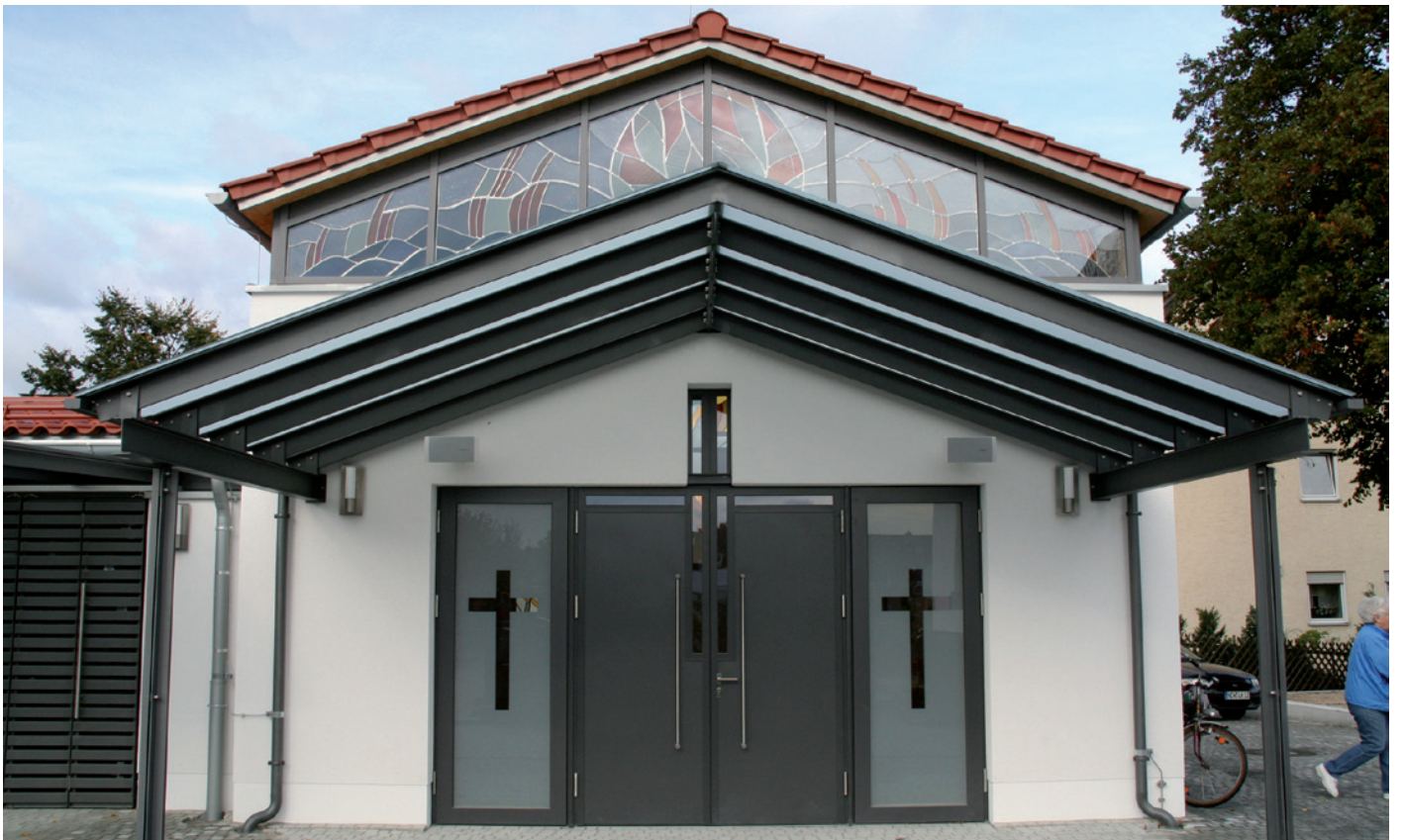
Die Aussegnungshalle soll einen ruhenden Pol bilden, eine Art schützende Hülle für den Besucher. Sie soll ein bewusstes Abschiednehmen von dem Toten ermöglichen.
