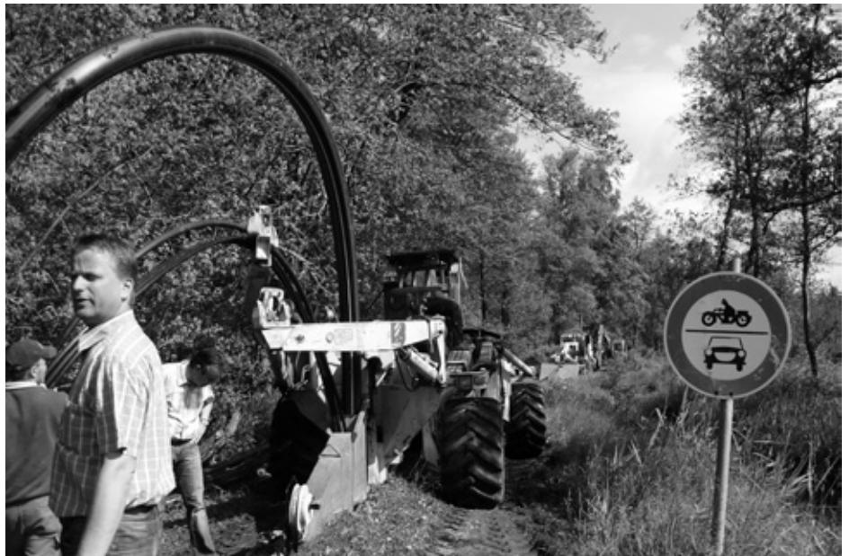
Unser Bild zeigt das Verfahren zum Einpflügen der Wasserleitung in die vorhandenen Forstwege.
