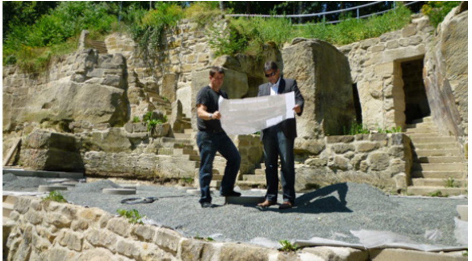
Während der Bauarbeiten: Stadtbaumeister Hans Rettinger erläuterte Bürgermeister Edgar Knobloch regelmäßig den Stand der Bauausführung. Die Sanierung der Naturbühne war auch für den erfahrenen Baufachmann eine neue Herausforderung.
