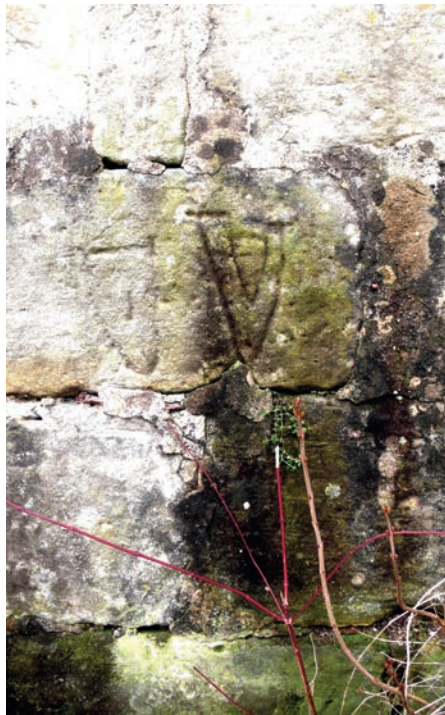
Foto: Reinhold Böhm, Bauinschrift am Schubpfeiler
