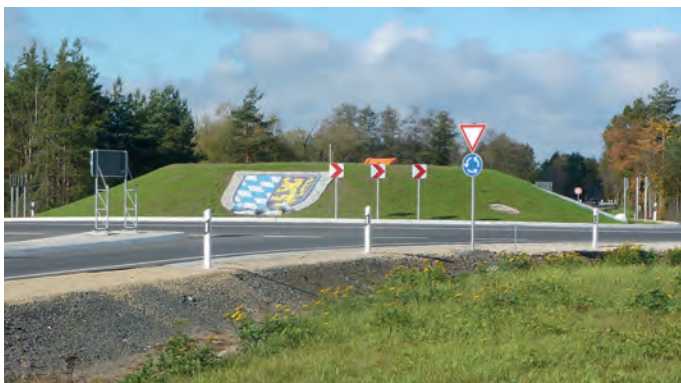
Neuerrichteter Kreisverkehr an der Wache 6
