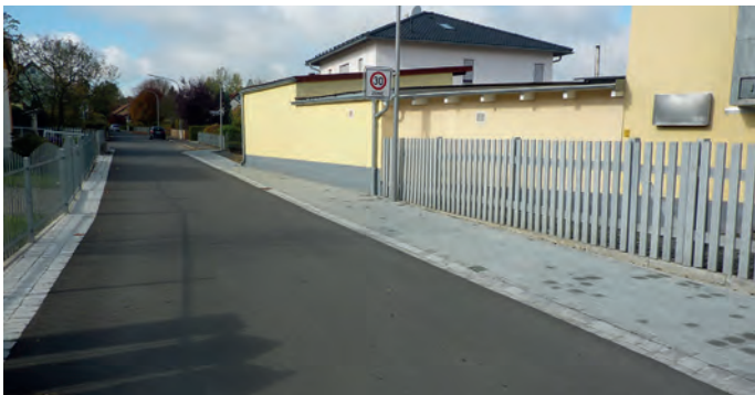
Fertigstellung des Ausbaus des Mittelbergwegs
